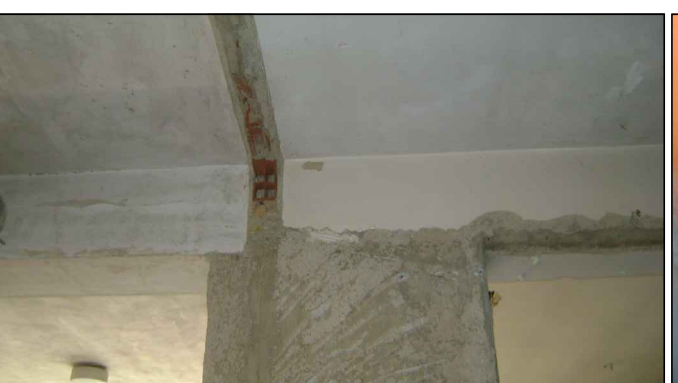
FOTO N° 7: Vista di dettaglio con traccia dei tramezzi interni demoliti e stonacatura pilastri
