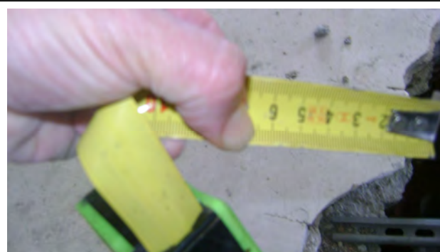
Immagine di dettaglio per spessore massetto-pavimento
