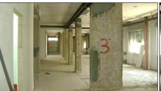
FOTO N° 1: Vista interna corpi B/A piano secondo, con demolizioni tramezzi, stonacatura pilastri e ripristini
