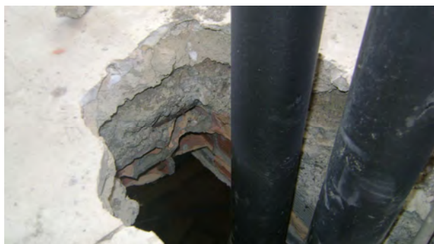
Immagine di dettaglio varchi per passaggio impianti
