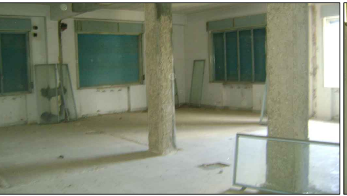
FOTO N° 5: Vista interna corpo A piano secondo. Evidenti demolizioni tramezzi, stonacatura pilastri e ripristini
