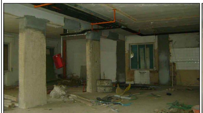
FOTO N° 1: Vista interna corpo C al piano terra, evidenti demolizioni tramezzi e ripristini strutture
