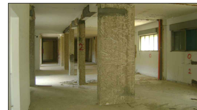
FOTO N° 4: Vista interna corpi B/A piano primo, evidenti demolizioni tramezzi, stonacatura pilastri e ripristini
