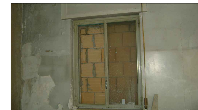
FOTO N° 3: Vista di dettaglio al piano terra corpo C con chiusura provvisoria finestre con fodera da B
