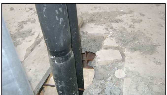
FOTO N° 12: Vista di dettaglio su vuoto per passaggio dei servizi, con evidenza spessore soletta e massetto
