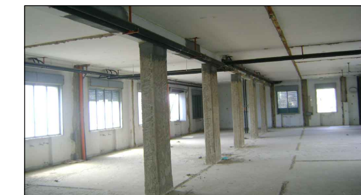
FOTO N° 4: Vista interna corpo C piano secondo, evidenti demolizioni tramezzi, stonacatura pilastri e ripristini
