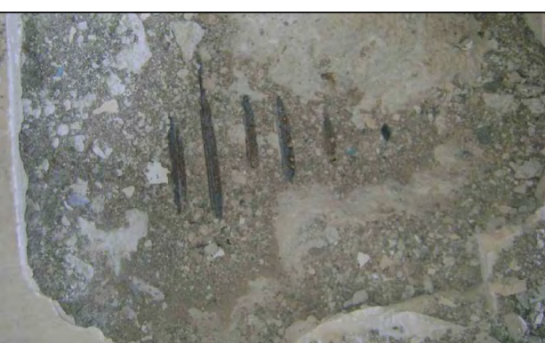
FOTO N° 11: Vista d'insieme saggio estradesso travi con evidenza armature a negativo su appoggio, Corpo B P.P.
