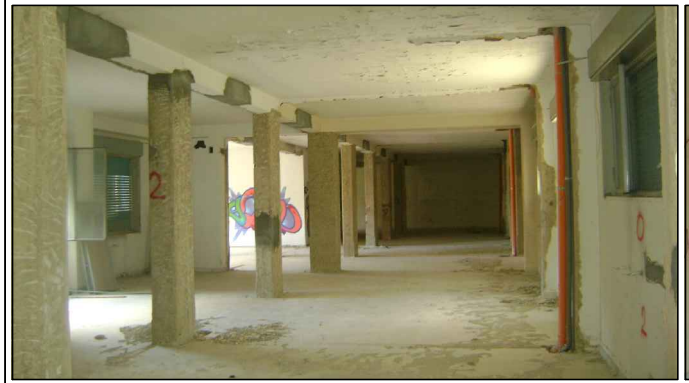
FOTO N° 5: Vista interna corpi B/A piano primo. Evidenti demolizioni tramezzi, stonacatura pilastri e ripristini
