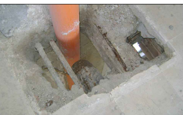
FOTO N° 11: Vista di dettaglio su vuoto per passaggio dei servizi, con evidenza spessore soletta e massetto
