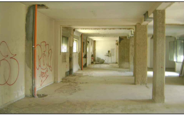
FOTO N° 6: Vista interna corpo B piano primo, evidenti demolizioni tramezzi, stonacatura pilastri e ripristini
