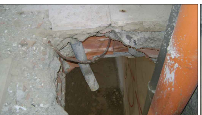
FOTO N° 10: Vista di dettaglio su vuoto per passaggio dei servizi, con evidenza spessore soletta e massetto
