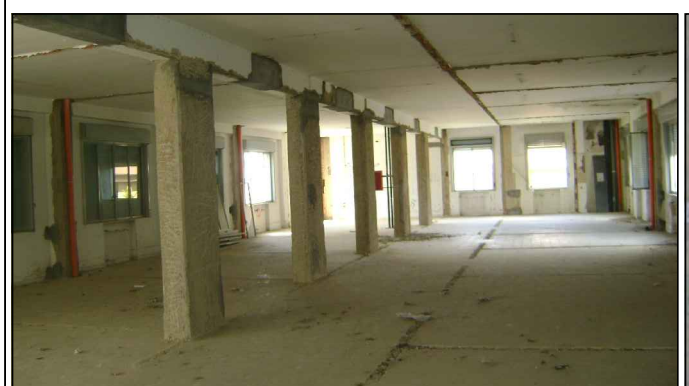
FOTO N° 10: Vista interna corpo C piano primo, evidenti demolizioni tramezzi, stonacatura pilastri e ripristini
