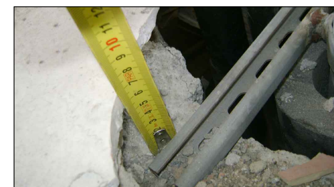
FOTO N° 13: Saggio eseguito al piano primo corpo C con evidenza pacchetto esistente pavimento/massetto s=6,7cm
