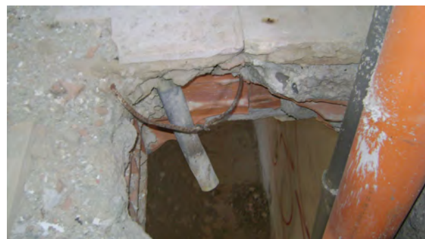
Ulteriore immagine di dettaglio varchi per impianti
