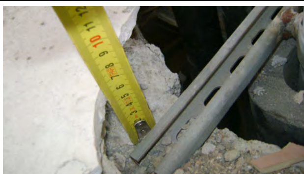
Immagine di dettaglio per spessore massetto-pavimento
