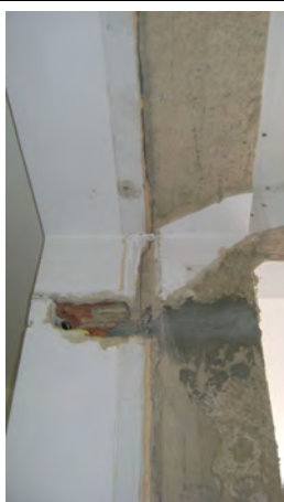
Giunto tra i corpi A e B al primo livello
