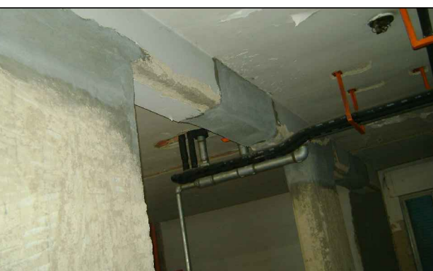
FOTO N° 2: Vista interna corpo C al piano terra, evidenti stonacatura dei pilastri e ripristini strutture
