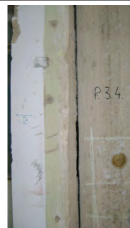
Giunto tra i corpi A e B al secondo livello
