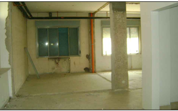
FOTO N° 6: Vista interna corpo A piano secondo, evidenti demolizioni tramezzi, stonacatura pilastri e ripristini
