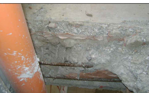
FOTO N° 8: Vista di dettaglio su vuoto per passaggio dei servizi, con evidenza spessore soletta e massetto
