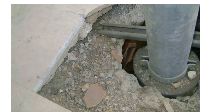
FOTO N° 12: Saggio eseguito al piano primo corpo C con evidenza pacchetto esistente pavimento/massetto s=6,7cm
