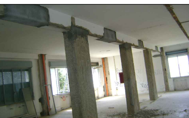
FOTO N° 8: Vista interna corpo C piano primo, evidenti demolizioni tramezzi, stonacatura pilastri e ripristini
