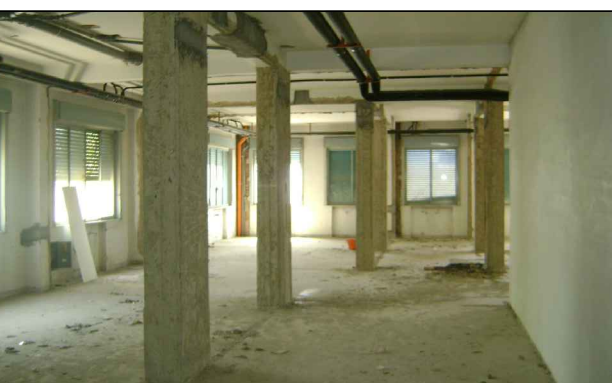
FOTO N° 2: Vista interna corpo B piano secondo, con demolizioni tramezzi, stonacatura pilastri e ripristini
