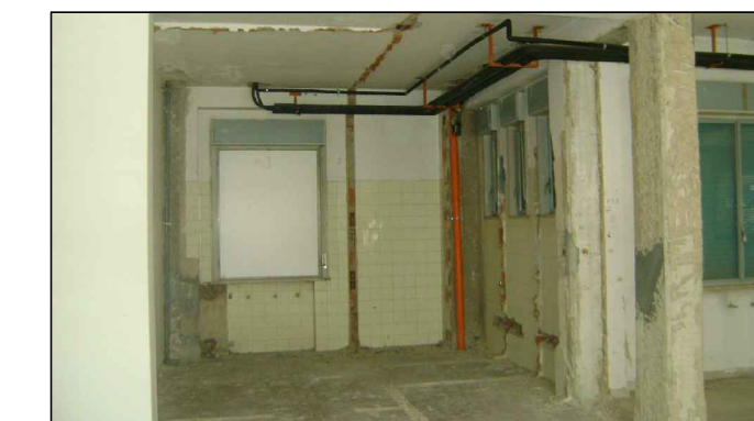
FOTO N° 3: Vista di dettaglio al piano secondo corpo B con tramezzature interne demolite zona bagni
